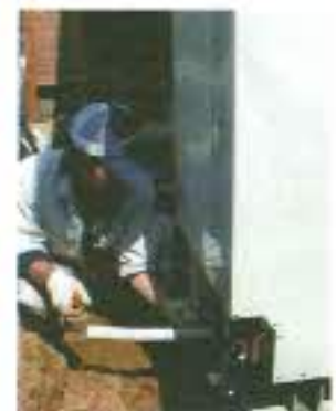
エコキュートの工事をしています
