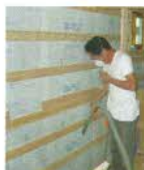
2階の壁に断熱材の吹き込みをしています。
