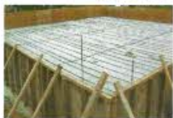
基礎工事・・・鉄筋を縦横にめぐらせています。
