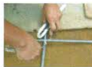
ハッカー使って手動で鉄筋を結束しています。
