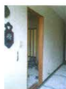
和室の入口です。壁を取り除き4枚の障子にしました。
