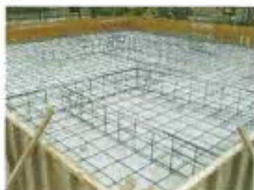
基礎工事・・・鉄筋を縦横にめぐらせています。
