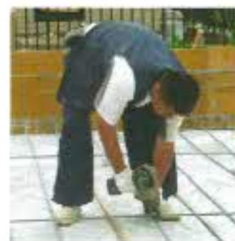
鉄筋を結束しています。
