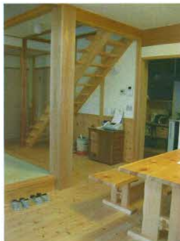
8寸の大黒柱がリビングの中央に。ストリップ階段がすっきりとした印象です。
