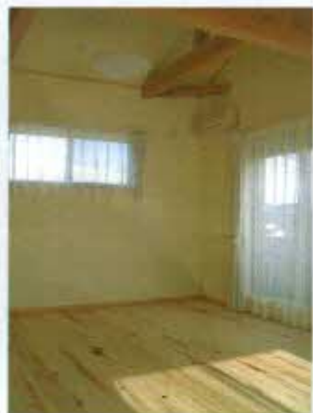
子供室の床はスギ材。窓が3方にあります。いずれ仕切れるようにドアを2つ付けました。
