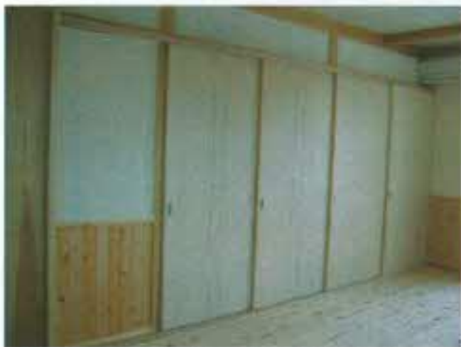
リビングと和室の間は4枚引き込み戸となっています。
