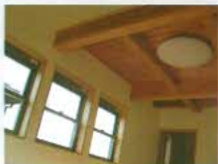
2階寝室の天井の板張り部分はロフトの床を兼ねています。
