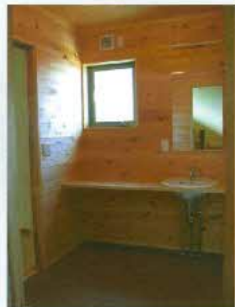
洗面所の壁天井はさわら、床はコルクです。
