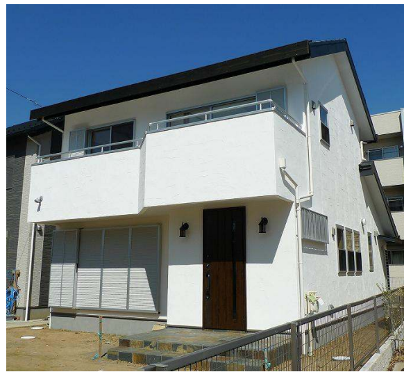
外壁も漆喰を塗りました。屋根は自然石（クールフグレー）・玄関ポーチは自然石（クールフブラウン）を使用。
