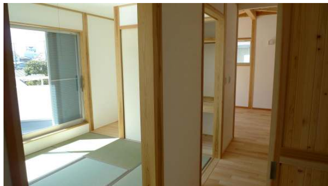
2階和室～洋室～ウォーキングクローゼット どこからも使いやすく！ 壁は漆喰を塗りました。
