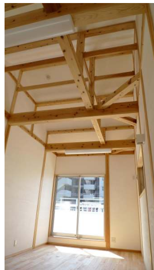
梁が見える2階の洋室
