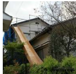
大工さんが作ってくれた 瓦下ろし用の滑り台
