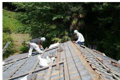
復旧現場の様子
