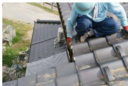
屋根の仕上げに、雨樋に詰まった土を取り除いてくれています。
