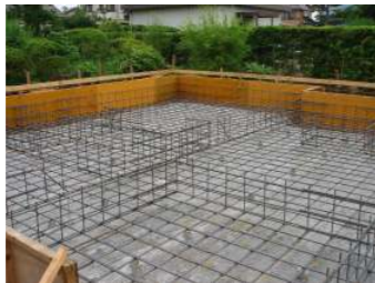
ベタ基礎のコンクリート打設
