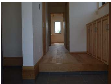
床材、玄関框は無垢のさくら材を使用
