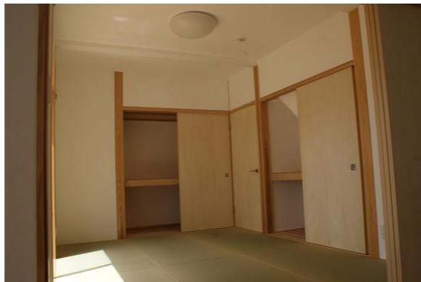
真壁作りの1階和室。 押入れの中まで壁は無添加漆喰です。
